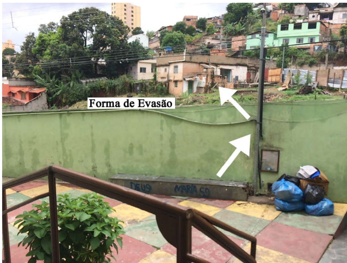
Figura 7 - Vista interna da Casa Francisca de Paula
