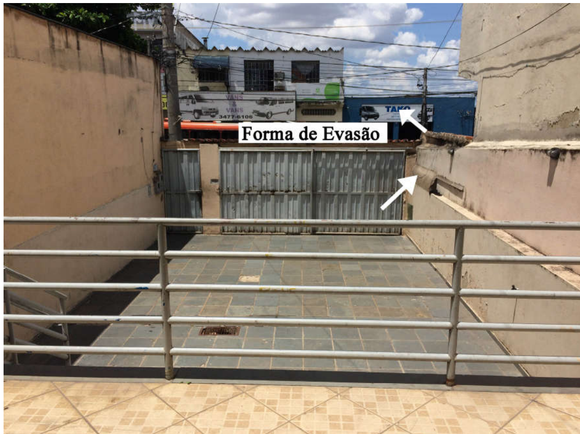
Figura 10 - Vista interna da Casa ADRA 3
