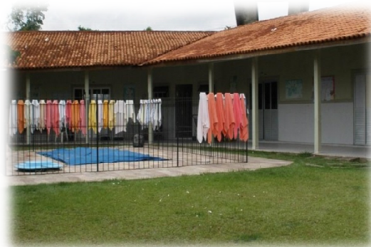
Figura 6. Vista parcial para o bloco de dormitórios e piscina.
