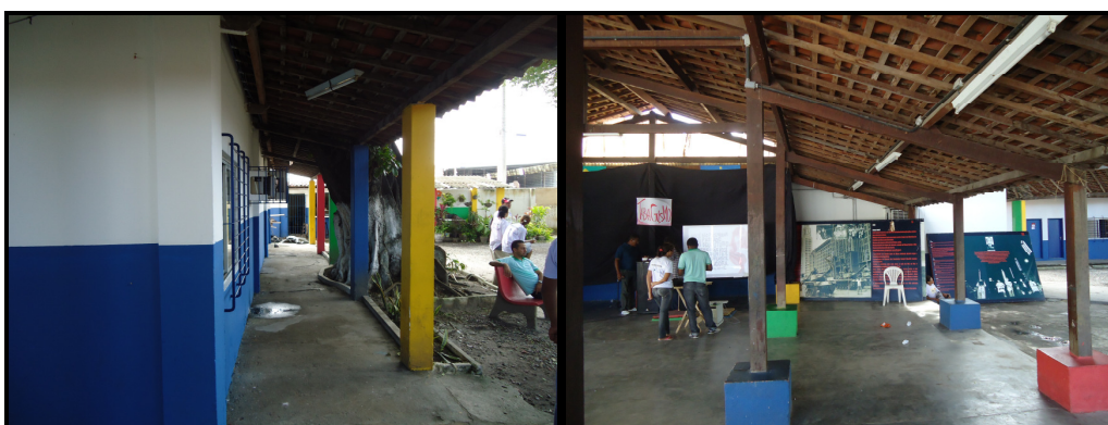
Corredor de salas de aula
