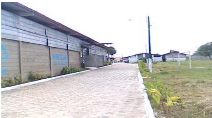
Foto 19 - Galpão de armazenamento do do pólo Benguí / foto: Marisa Pinheiro
