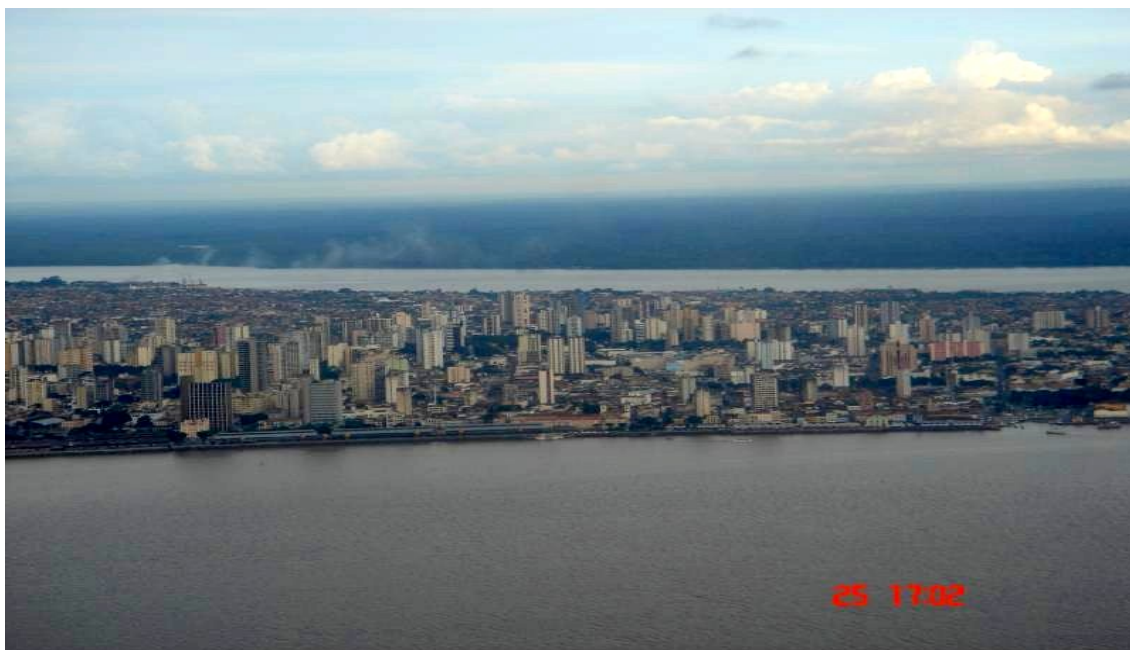
Foto 1 - O rio que passa ao fundo é o Guamá e o que se apresenta a frente é a baía do Guajará – Foto: www.pará.gov.br
